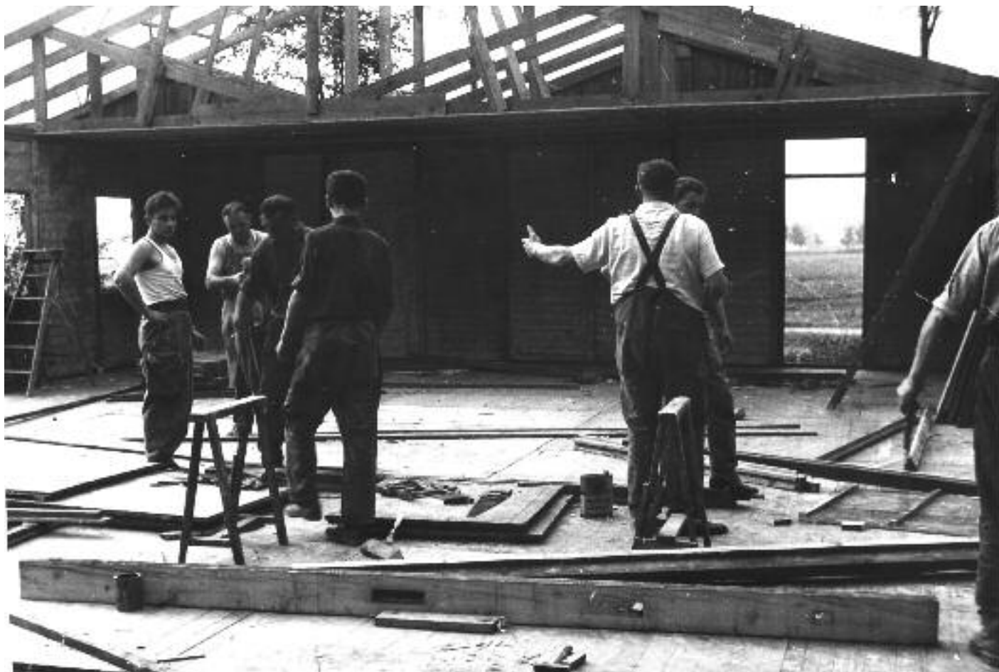
Construction du chalet de l'Amitié
