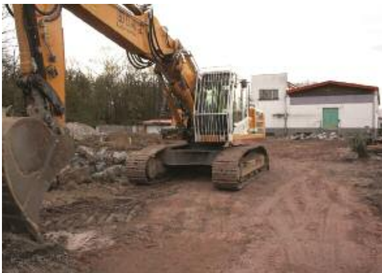
Le chalet a été démolé. Les travaux de gros oeuvre ont commencé.
