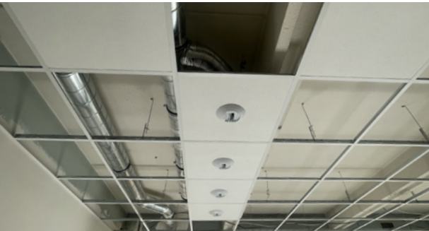
Rénovation des plafonds et équipement en LED
