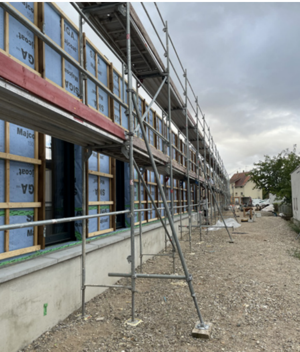
Chantier Tulipes-Vosges (septembre 2026)
